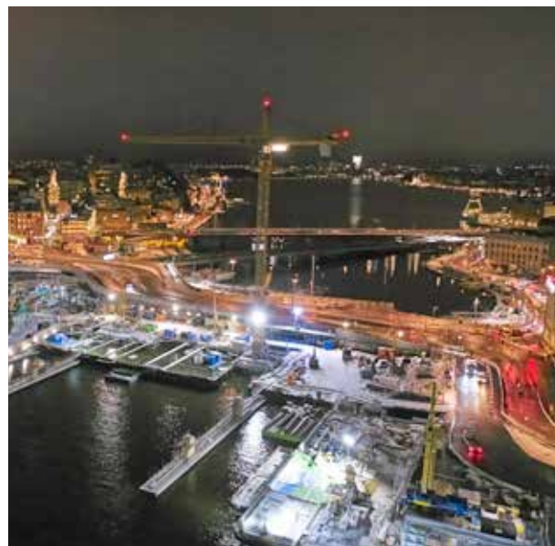
Från Gamla stans tunnelbanestation till Kornhamnstorg löper omkring 500 meter SoundGuard, skalskyddet för både arbetsplatsen och trafikanterna.
